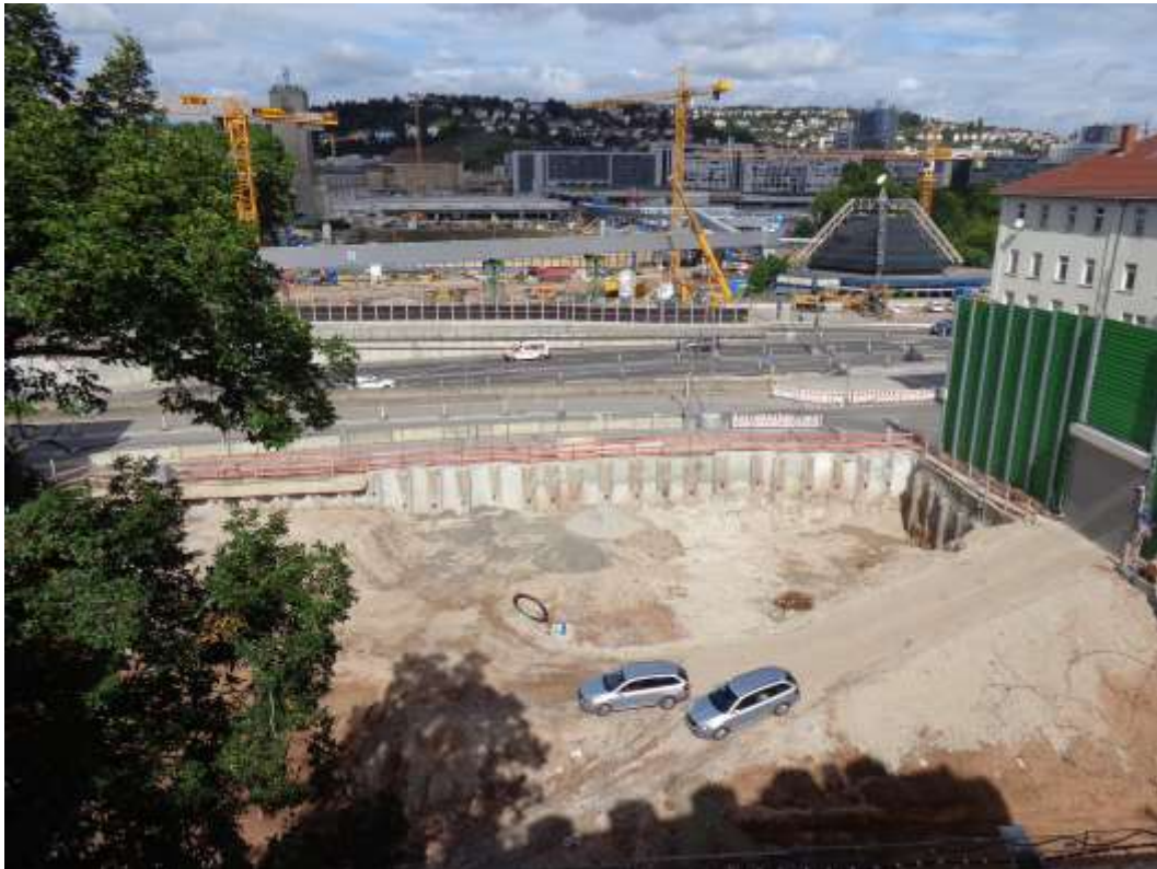
Abbildung 2: Blick auf das Baufeld bei Messende am 22.08.2016
