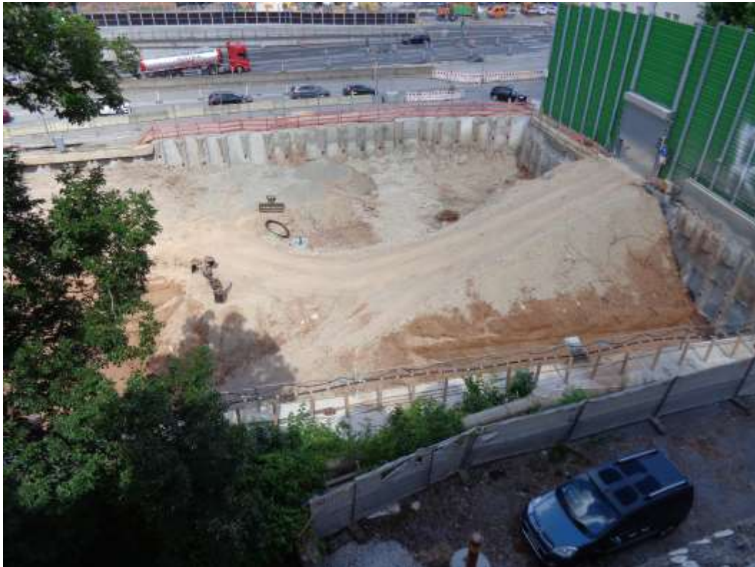
Abbildung 2: Blick auf das Baufeld bei Messende am 01.08.2016
