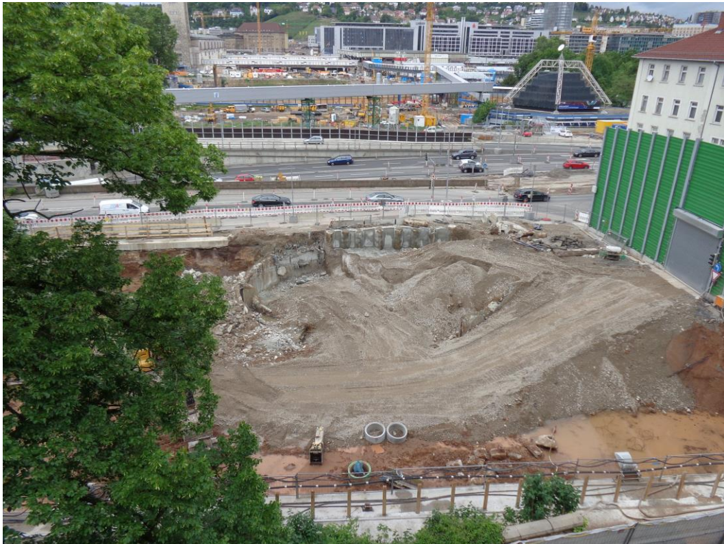
Abbildung 2: Blick auf das Baufeld bei Messende am 30.05.2016
