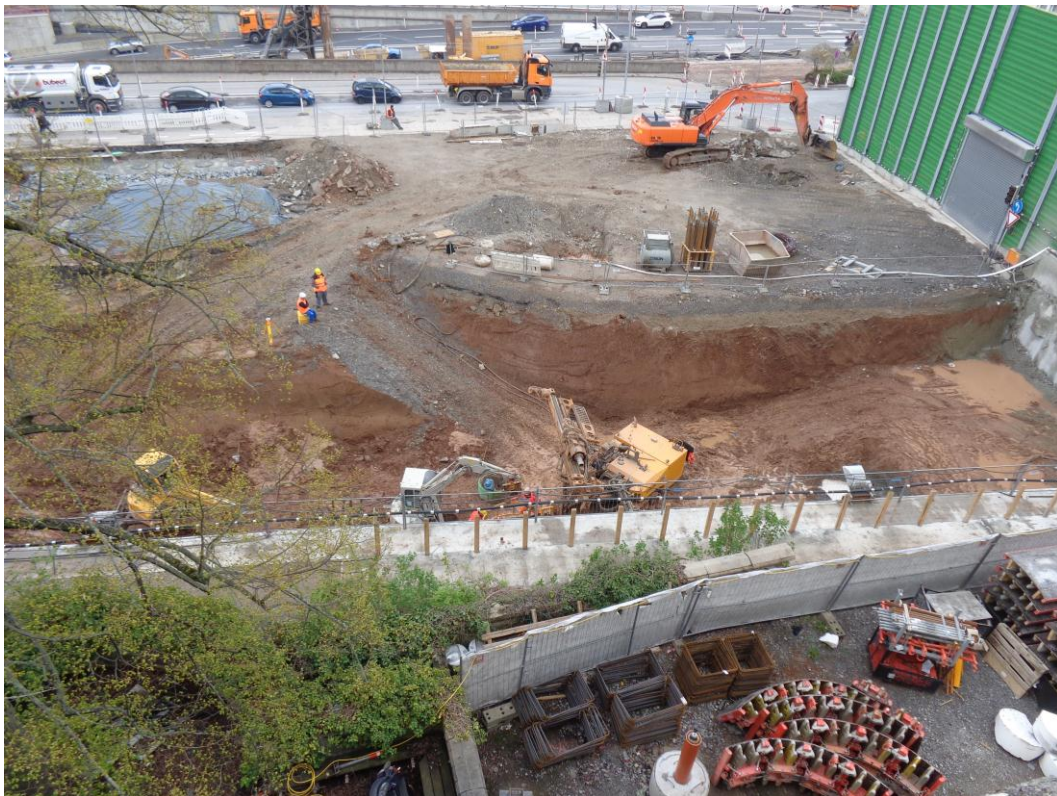
Abbildung 2: Blick auf das Baufeld bei Messende am 18.04.2016
