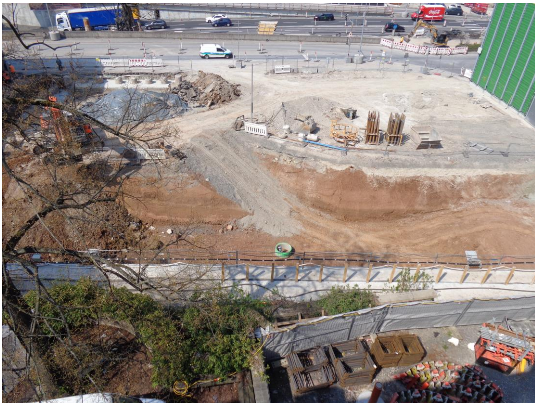
Abbildung 1: Blick auf das Baufeld bei Messbeginn am 11.04.2016
