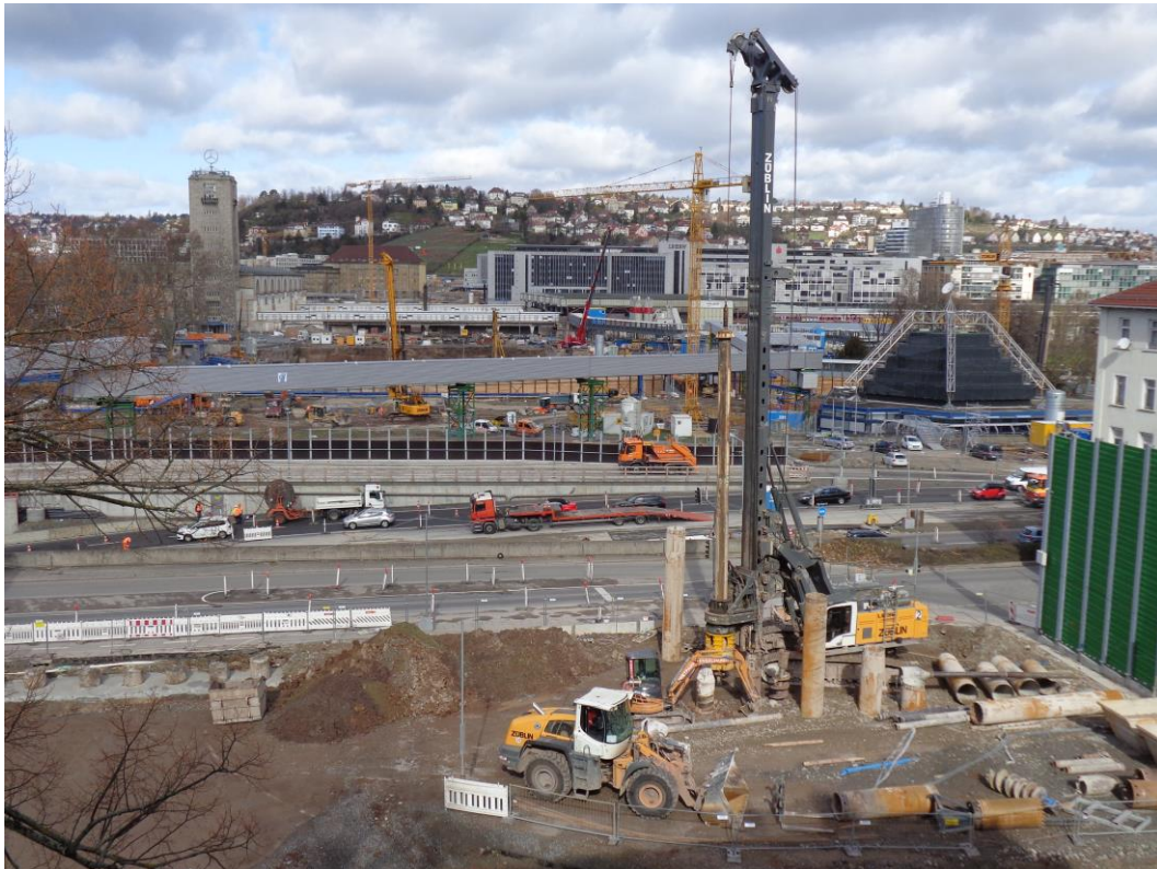
Abbildung 2: Blick auf das Baufeld bei Messende am 29.03.2016
