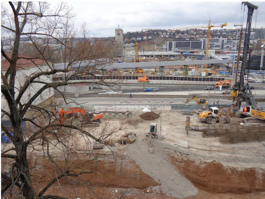
Abbildung 1: Blick auf das Baufeld bei Messbeginn am 21.03.2016
