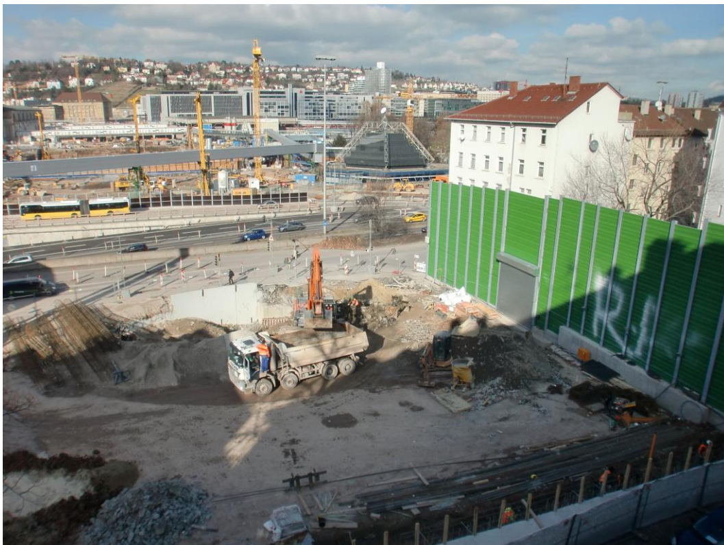
Abbildung 1: Blick auf das Baufeld bei Messbeginn am 12.02.2016
