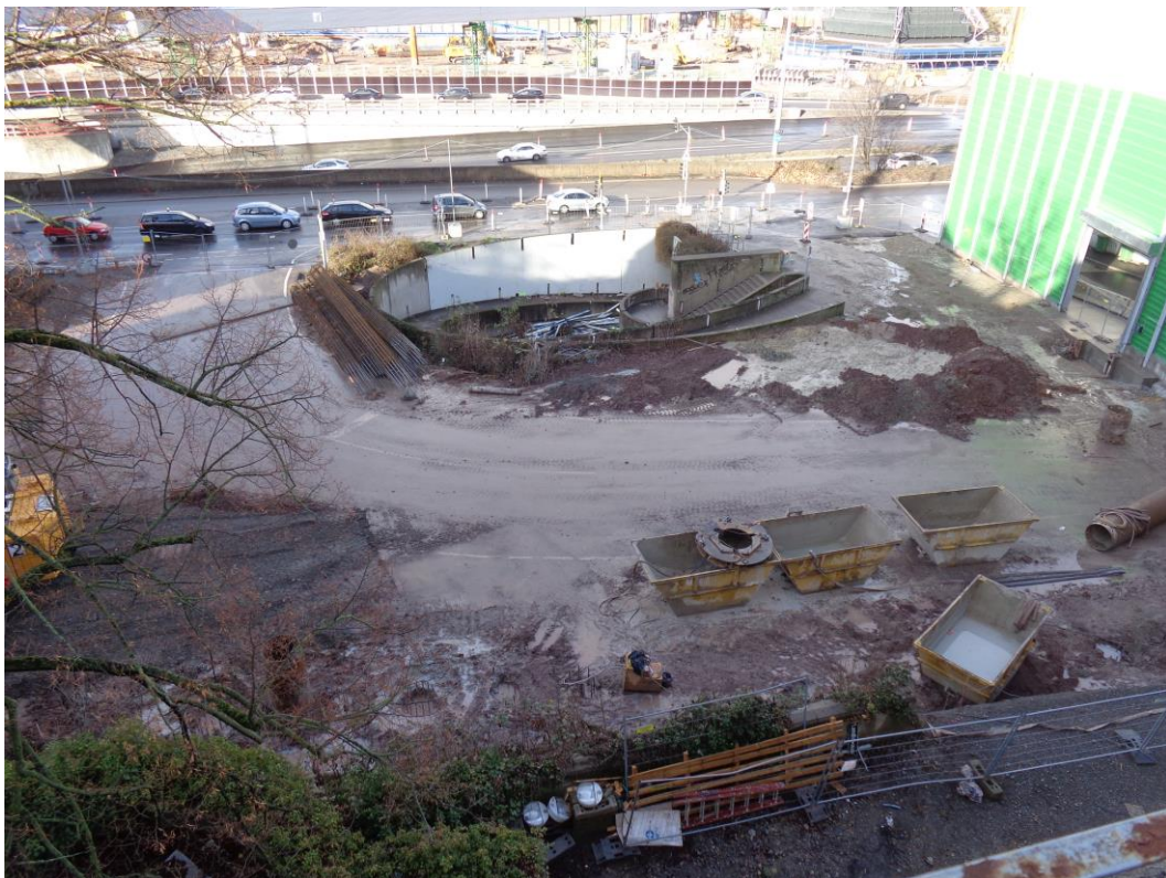
Abbildung 1: Blick auf das Baufeld bei Messbeginn am 04.01.2016
