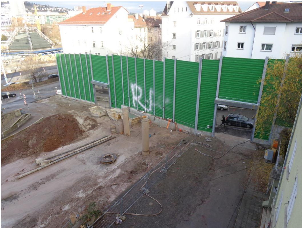
Abbildung 2: Blick auf das Baufeld bei Messende am 18.12.2015
