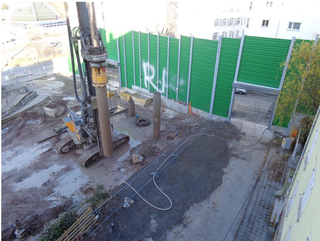
Abbildung 1: Blick auf das Baufeld bei Messbeginn am 14.12.2015
