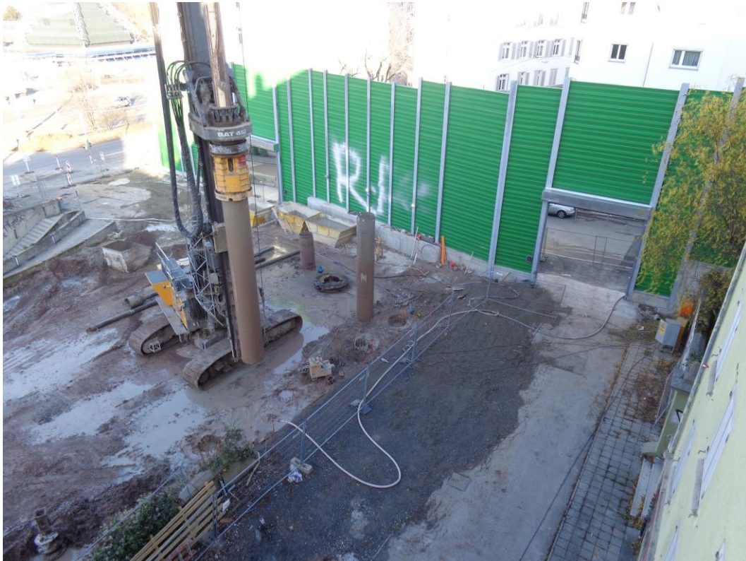
Abbildung 2: Blick auf das Baufeld bei Messende am 14.12.2015
