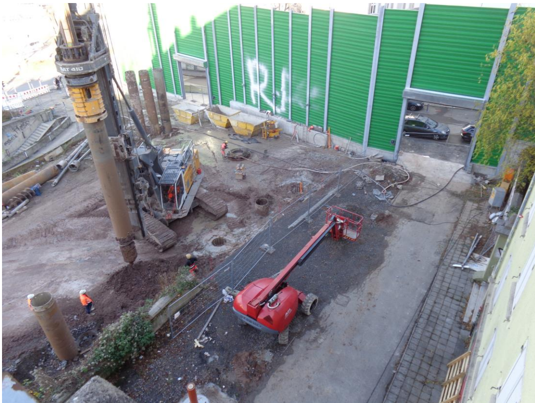
Abbildung 1: Blick auf das Baufeld bei Messbeginn am 07.12.2015
