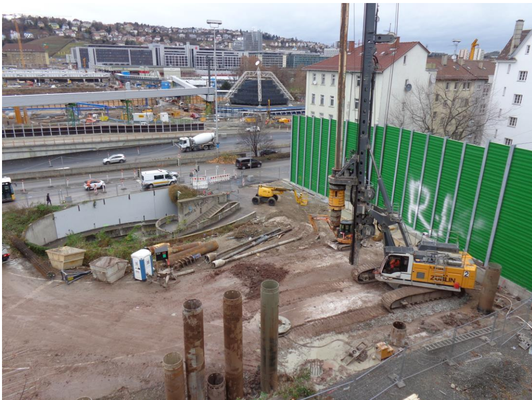
Abbildung 1: Blick auf das Baufeld bei Messbeginn am 23.11.2015
