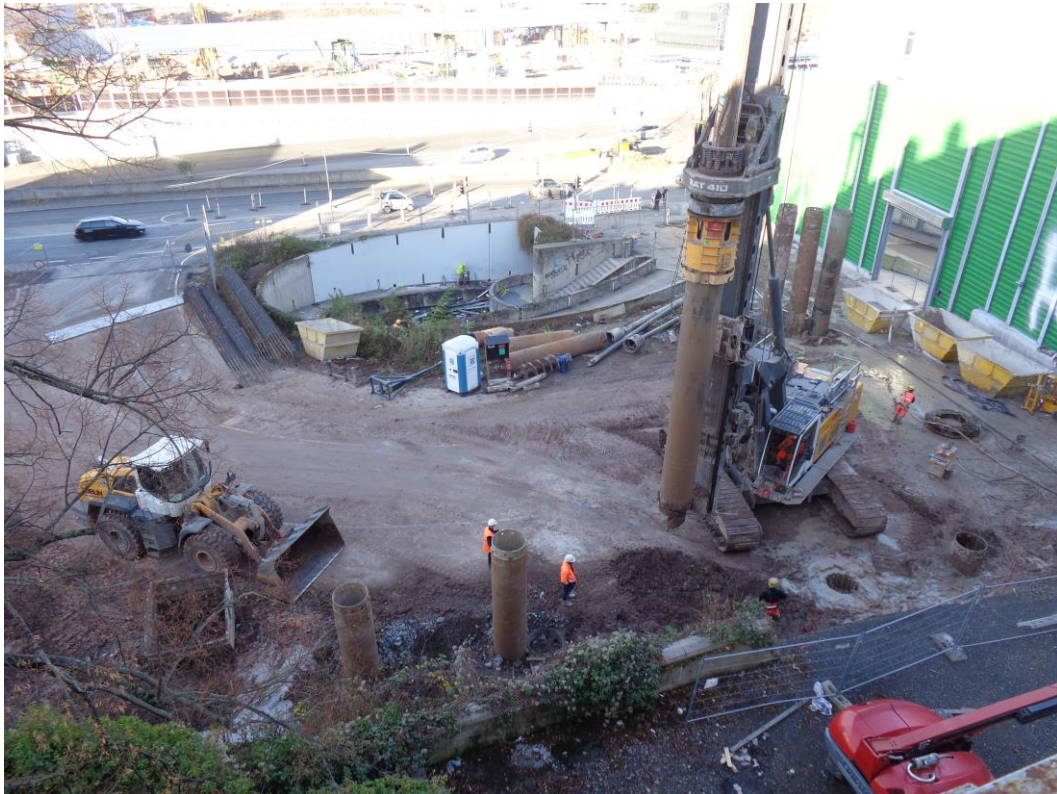
Abbildung 2: Blick auf das Baufeld bei Messende am 30.11.2015
