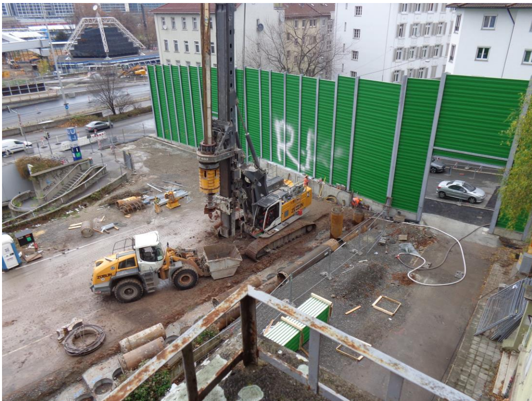
Abbildung 1: Blick auf das Baufeld bei Messbeginn am 23.11.2015
