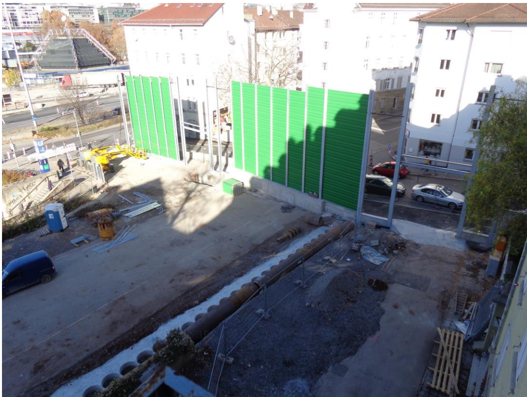
Abbildung 1: Blick auf das Baufeld bei Messbeginn am 16.11.2015
