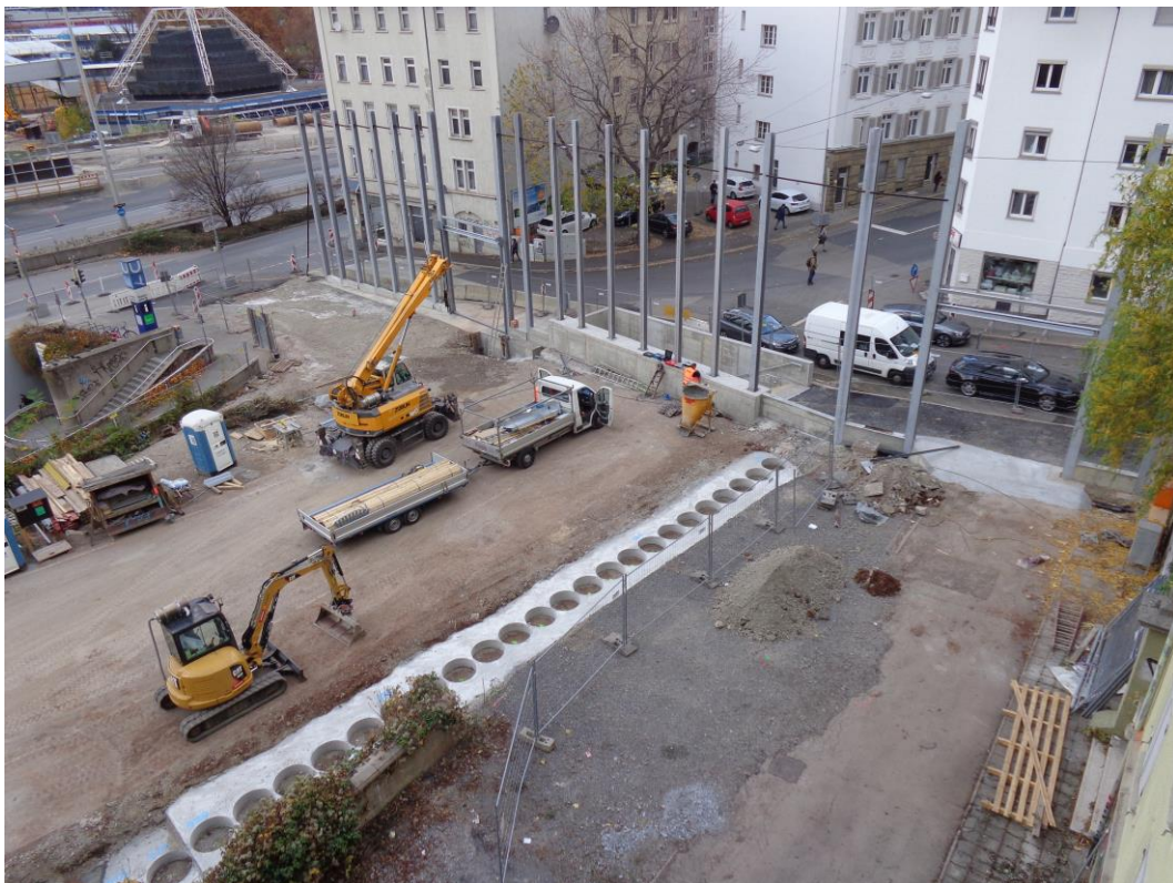
Abbildung 1: Blick auf das Baufeld bei Messbeginn am 09.11.2015
