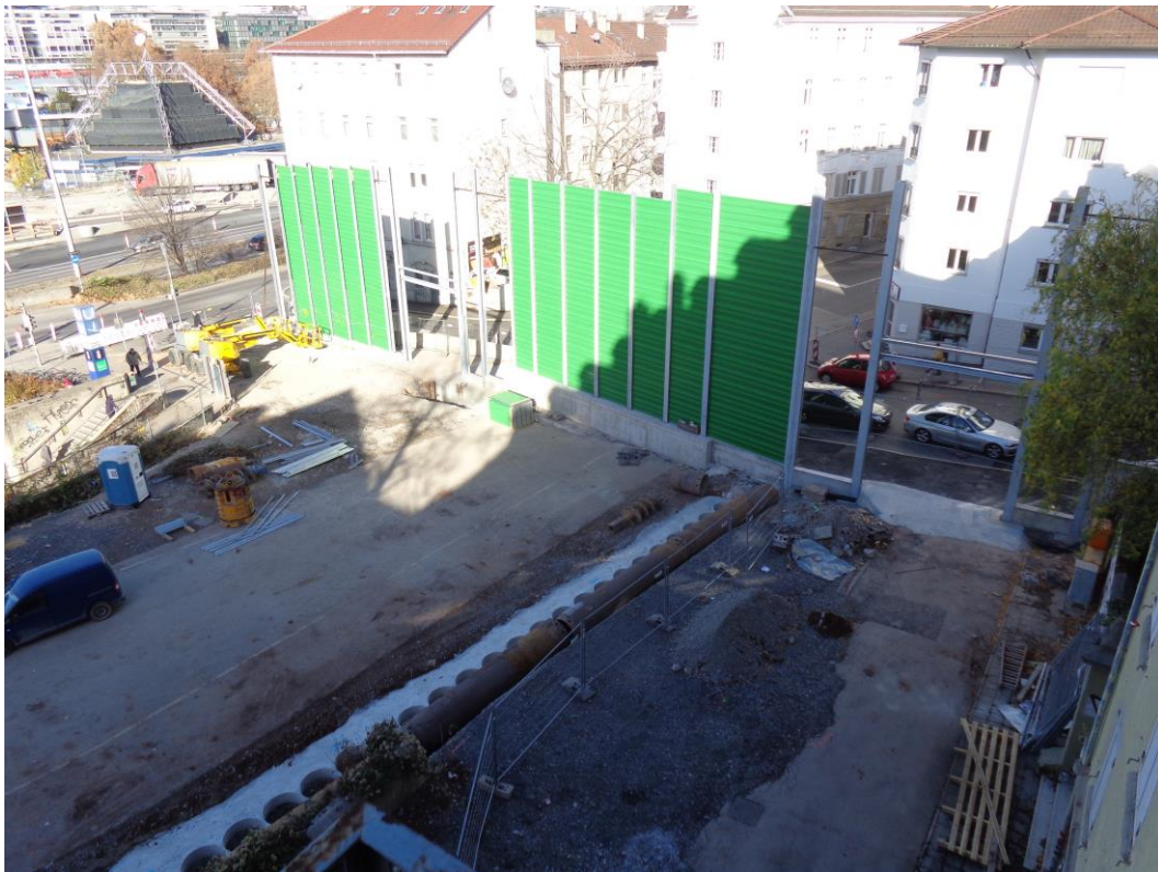
Abbildung 2: Blick auf das Baufeld bei Messende am 16.11.2015
