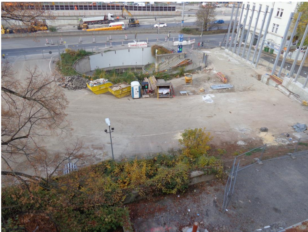
Abbildung 1: Blick auf das Baufeld bei Messbeginn am 02.11.2015
