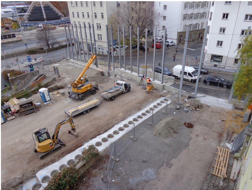
Abbildung 2: Blick auf das Baufeld bei Messende am 09.11.2015
