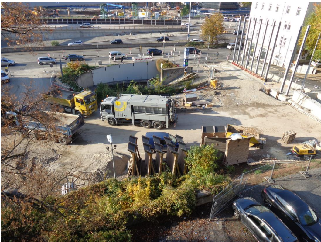
Abbildung 1: Blick auf das Baufeld bei Messbeginn am 26.10.2015
