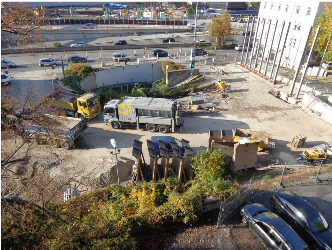
Abbildung 2: Blick auf das Baufeld bei Messende am 26.10.2015
