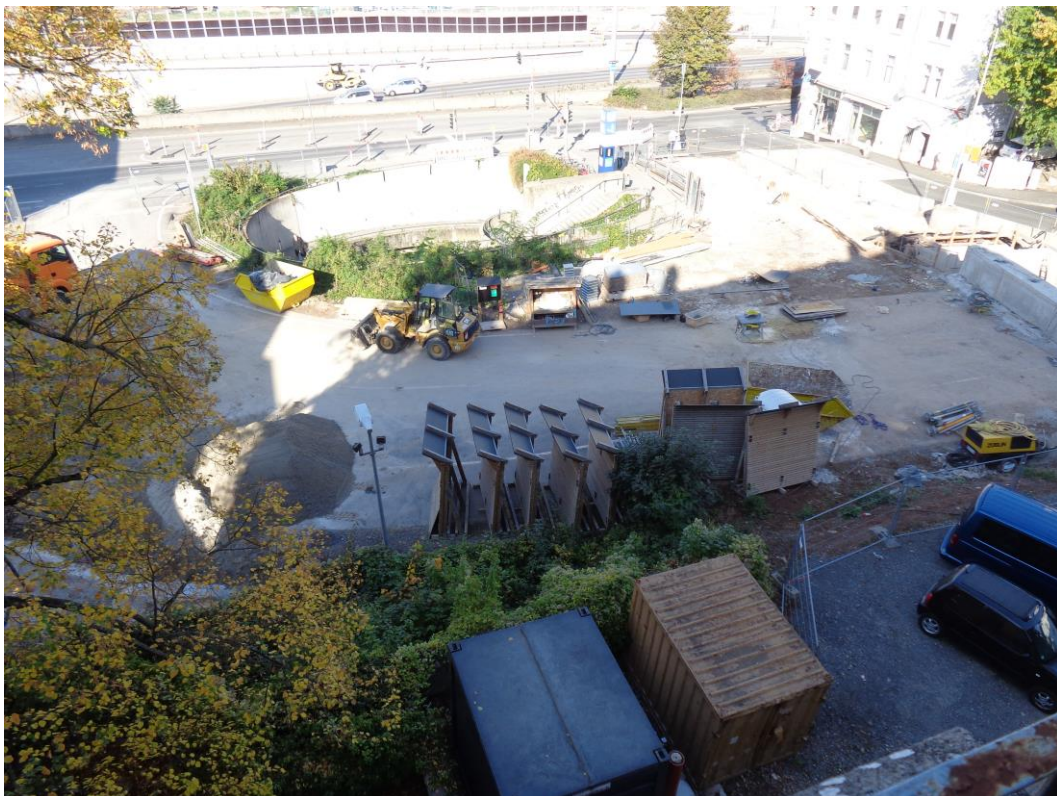
Abbildung 1: Blick auf das Baufeld bei Messbeginn am 12.10.2015
