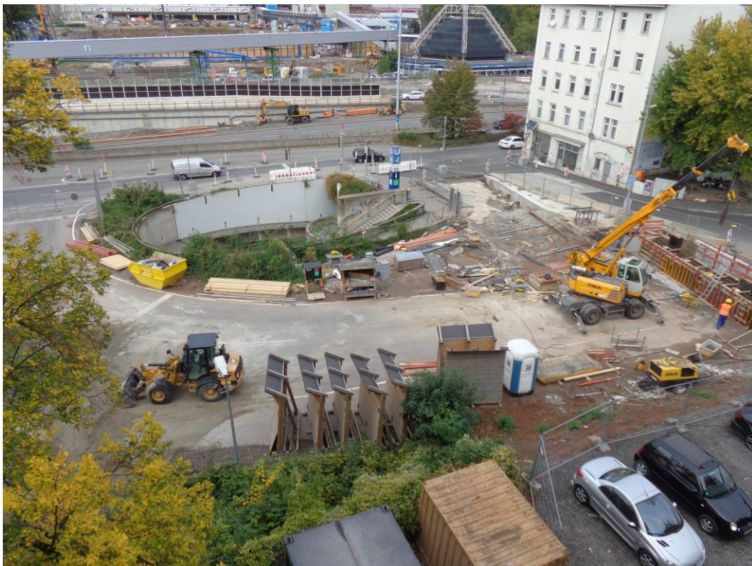
Abbildung 1: Blick auf das Baufeld bei Messbeginn am 05.10.2015
