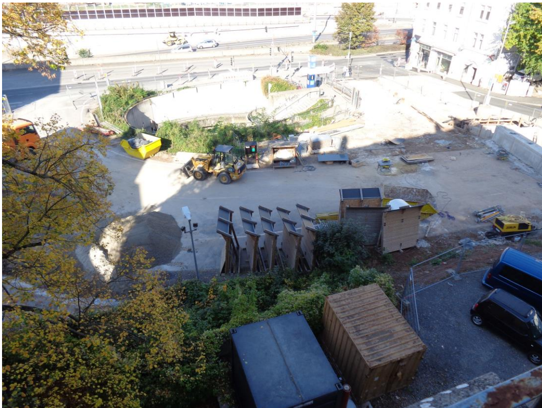
Abbildung 2: Blick auf das Baufeld bei Messende am 12.10.2015
