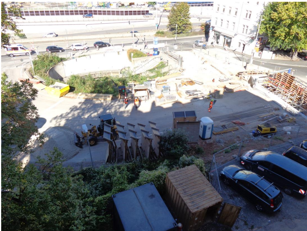
Abbildung 1: Blick auf das Baufeld bei Messbeginn am 28.09.2015
