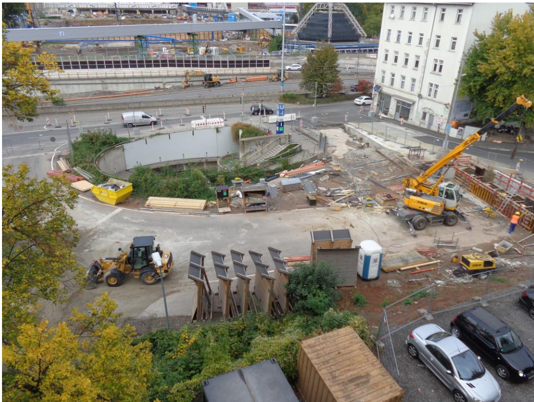
Abbildung 2: Blick auf das Baufeld bei Messende am 05.10.2015
