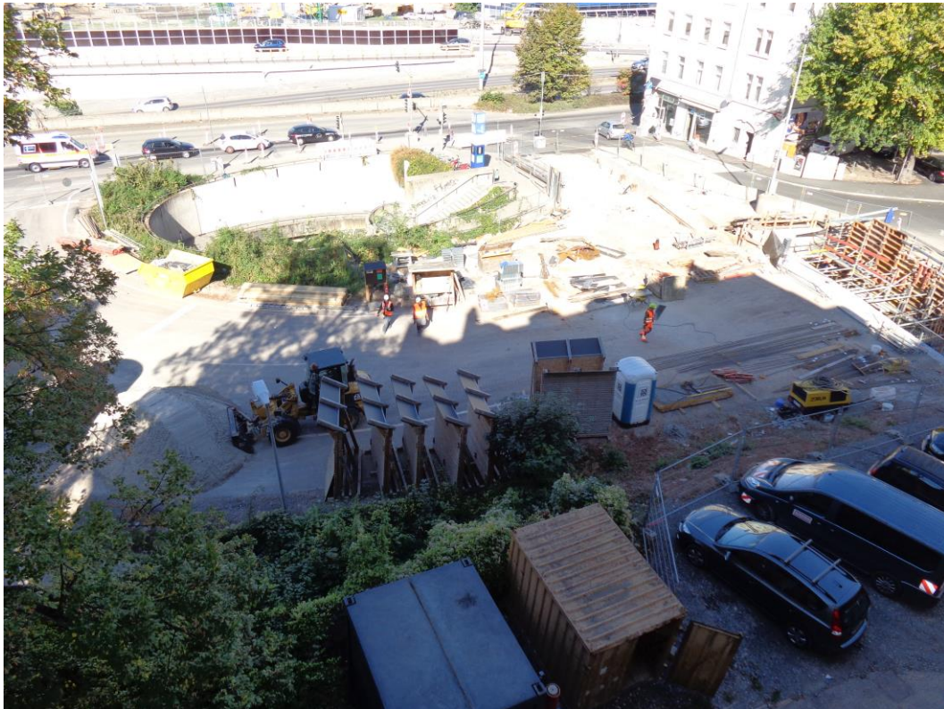
Abbildung 2: Blick auf das Baufeld bei Messende am 28.09.2015
