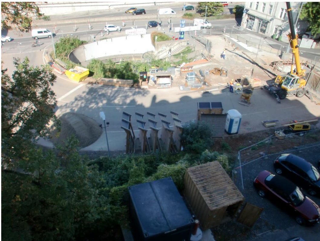
Abbildung 1: Blick auf das Baufeld bei Messbeginn am 21.09.2015
