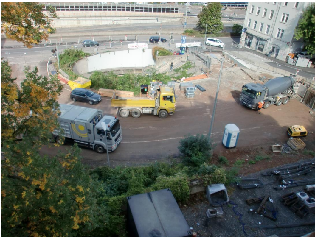
Abbildung 1: Blick auf das Baufeld bei Messbeginn am 14.09.2015
