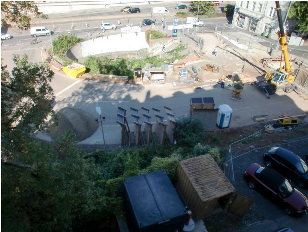
Abbildung 2: Blick auf das Baufeld bei Messende am 21.09.2015
