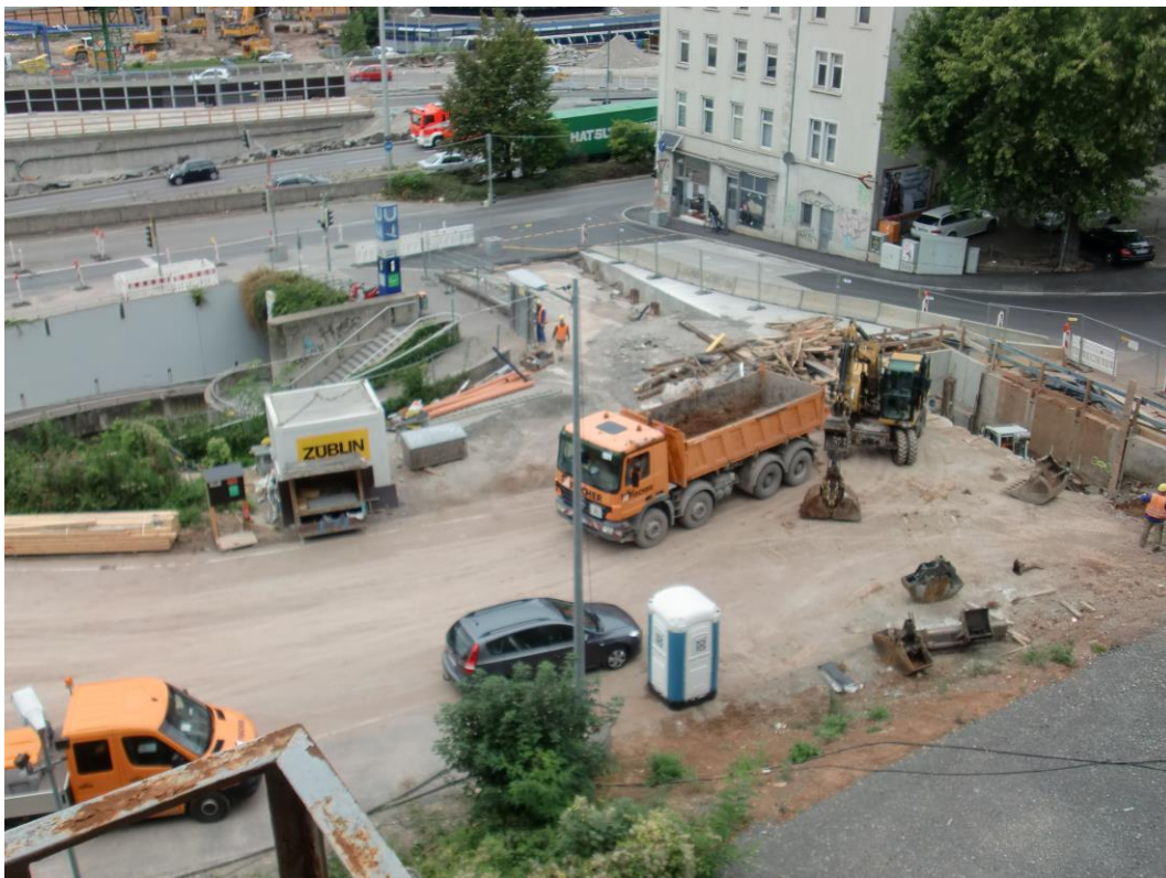
Abbildung 1: Blick auf das Baufeld bei Messbeginn am 07.09.2015
