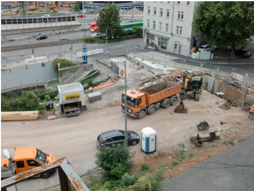
Abbildung 2: Blick auf das Baufeld bei Messende am 07.09.2015
