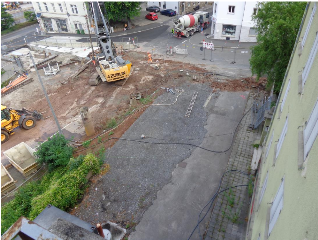
Abbildung 2: Blick auf das Baufeld bei Messende am 10.08.2015
