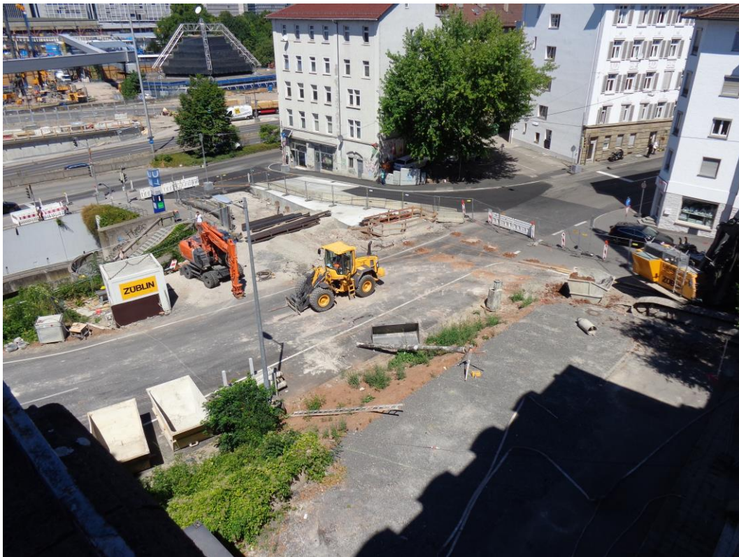
Abbildung 2: Blick auf das Baufeld bei Messende am 03.08.2015
