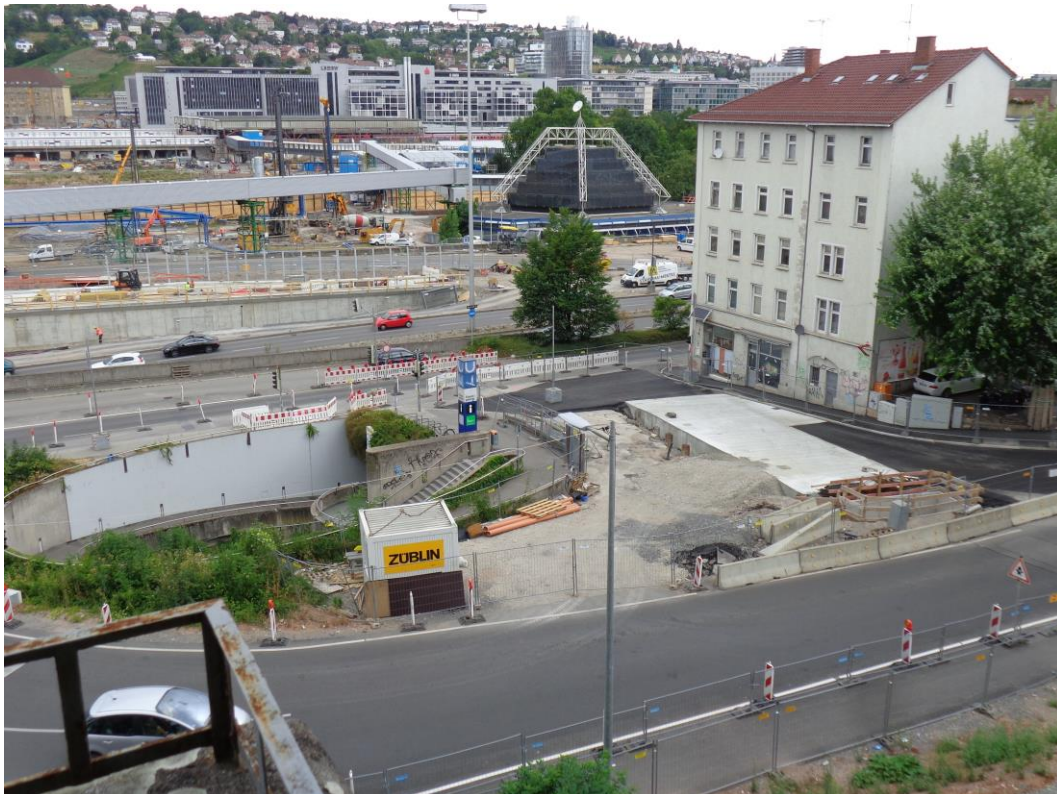
Abbildung 2: Blick auf das Baufeld bei Messende am 27.07.2015
