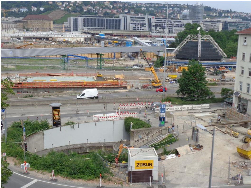
Abbildung 2: Blick auf das Baufeld bei Messende am 15.06.2015
