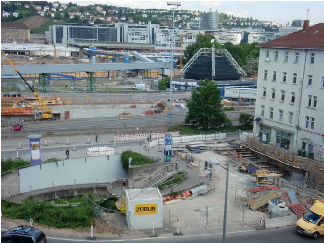
Abbildung 2: Blick auf das Baufeld bei Messende am 18.05.2015
