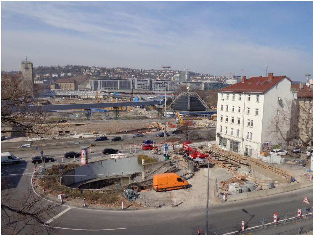
Abbildung 2: Blick auf das Baufeld bei Messende am 16.03.2015
