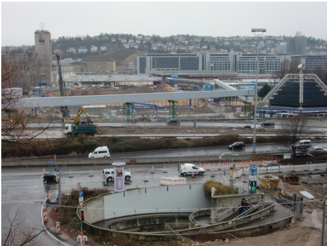
Abbildung 2: Blick auf das Baufeld bei Messende am 19.02.2015
