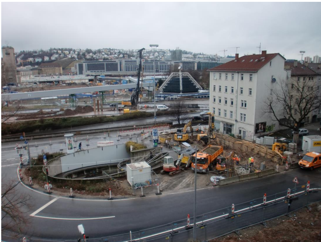
Abbildung 1: Blick auf das Baufeld bei Messbeginn am 02.02.2015
