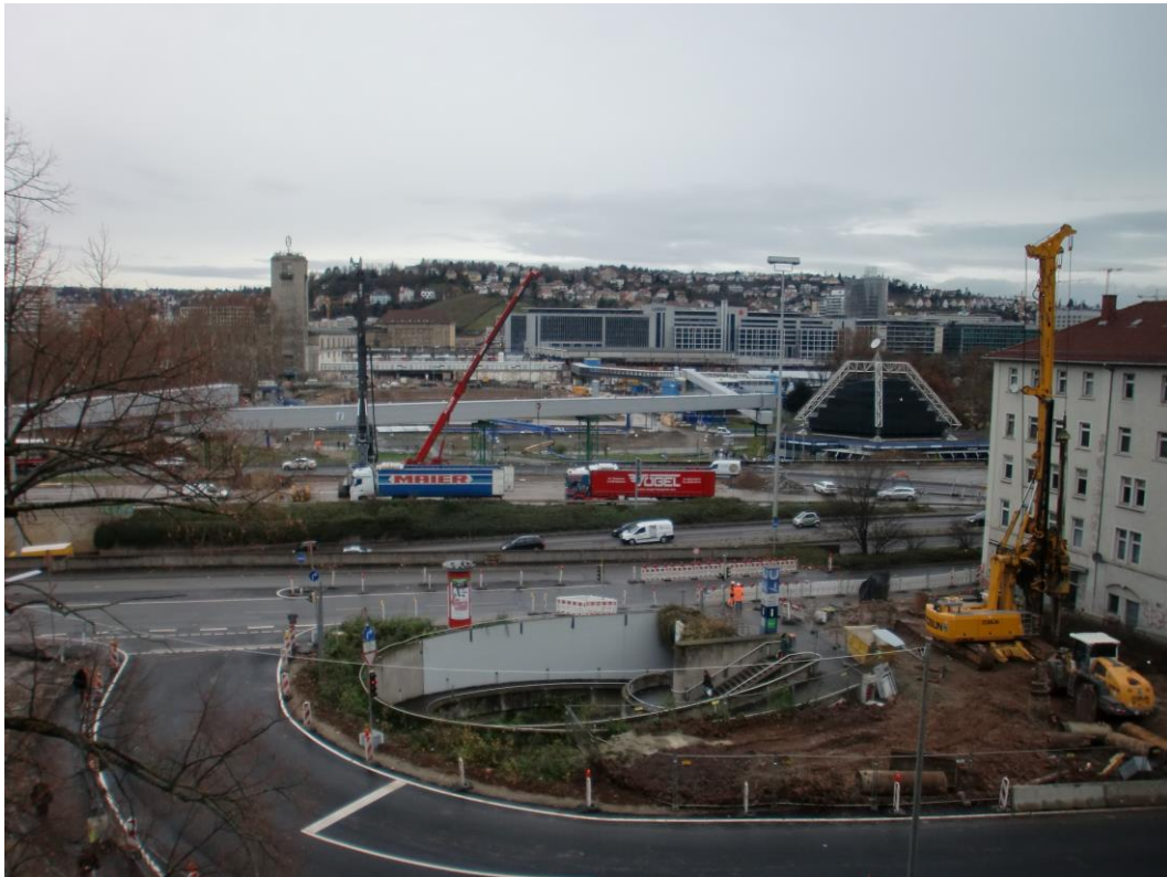
Abbildung 2: Blick auf das Baufeld bei Messende am 11.12.2014
