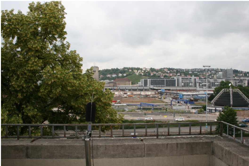
Abbildung 1: Messposition mit Blick auf die Baustelle
