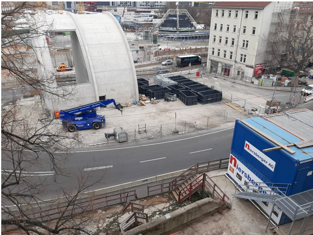
Abbildung 2: Blick auf das Baufeld bei Messende am 06.03.2023
