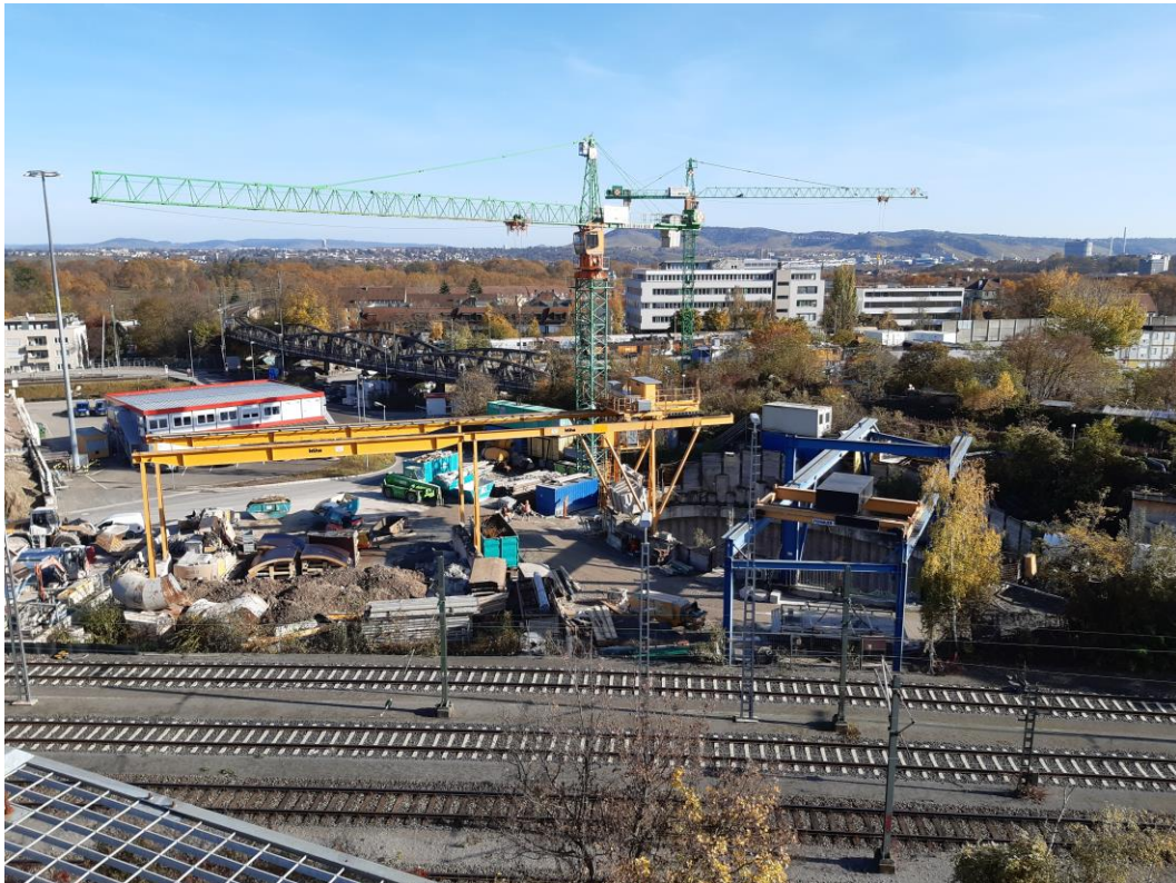
Abbildung 2: Blick auf das Baufeld bei Messende am 08.11.2021
