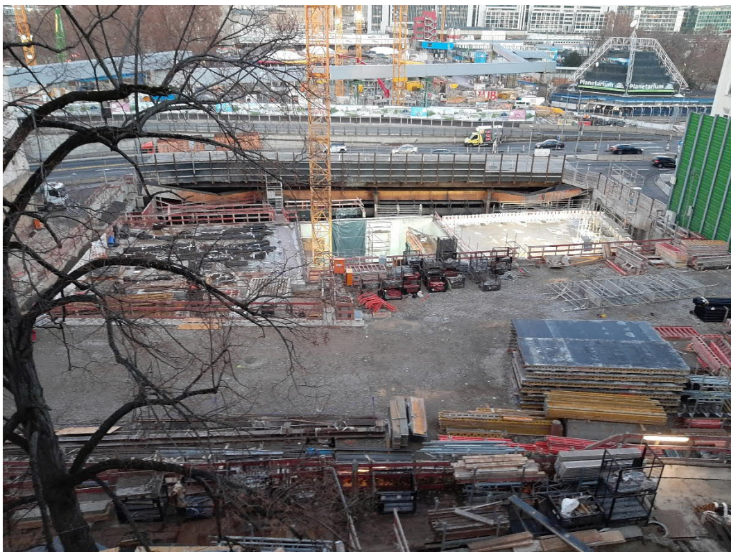
Abbildung 2: Blick auf das Baufeld bei Messende am 14.01.2020
