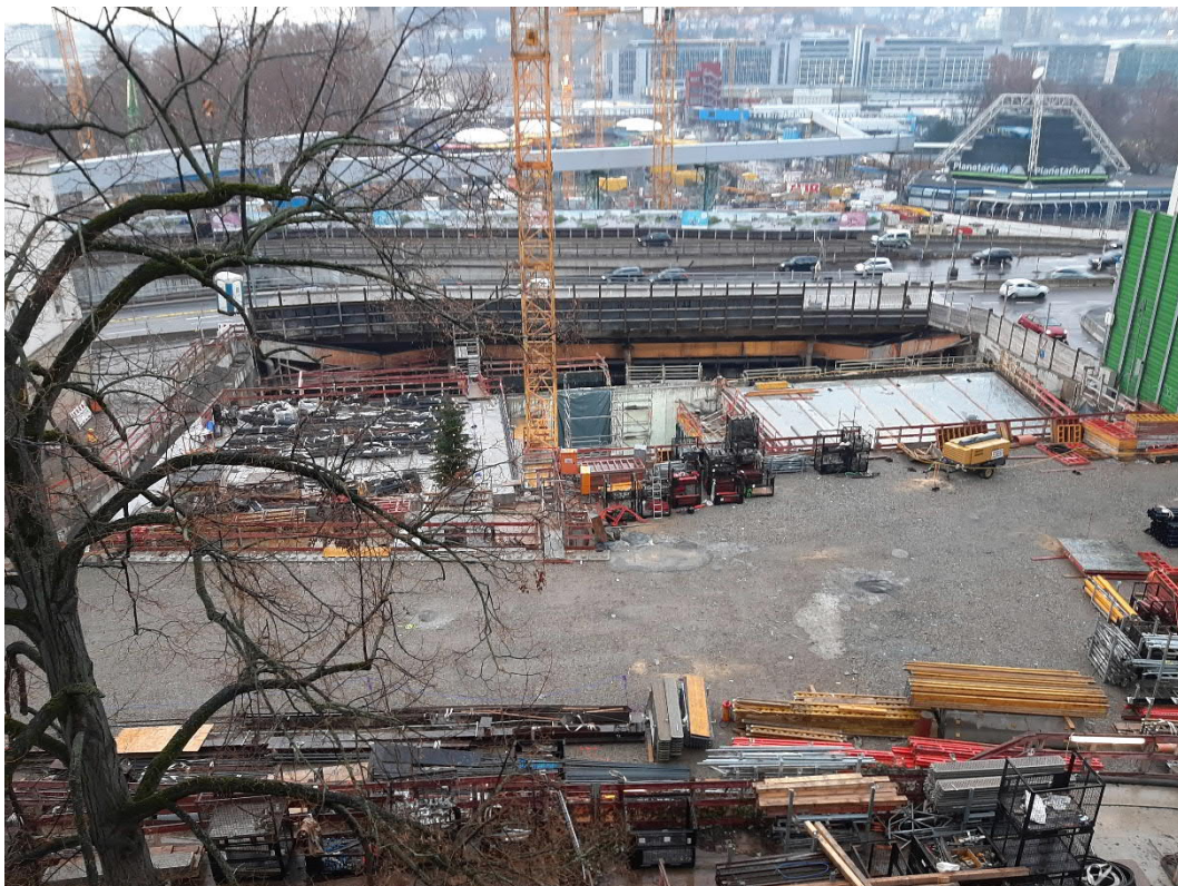
Abbildung 1: Blick auf das Baufeld bei Messbeginn am 07.01.2020
