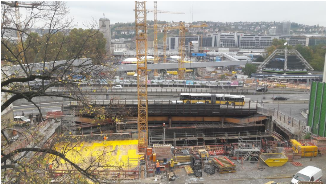
Abbildung 2: Blick auf das Baufeld bei Messende am 29.10.2019
