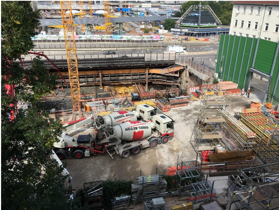
Abbildung 2: Blick auf das Baufeld bei Messende am 10.09.2019
