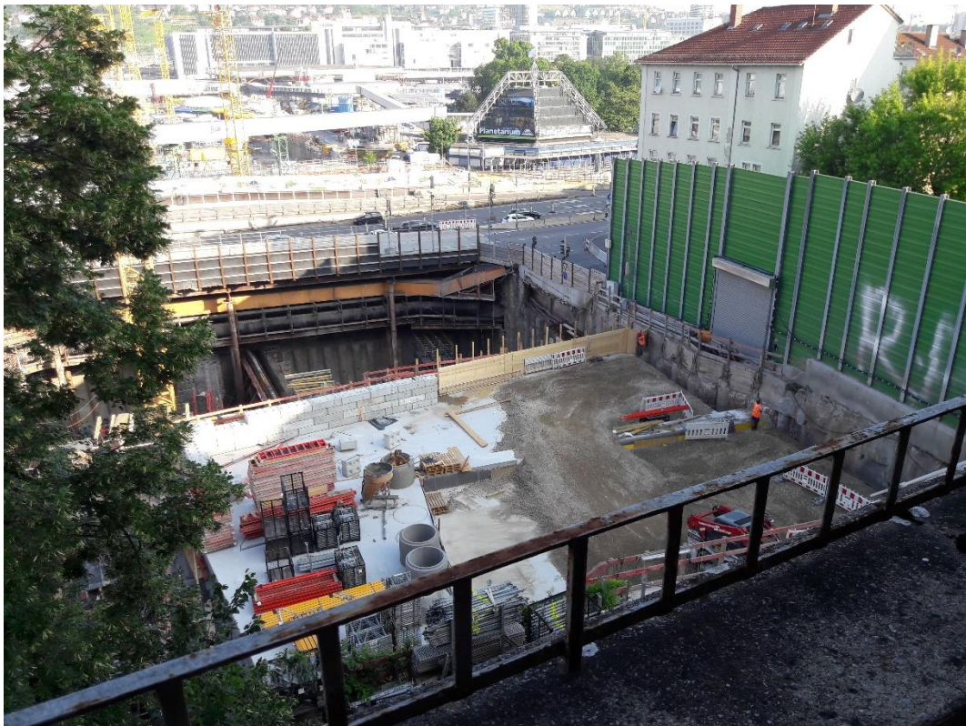
Abbildung 2: Blick auf das Baufeld bei Messende am 16.07.2019
