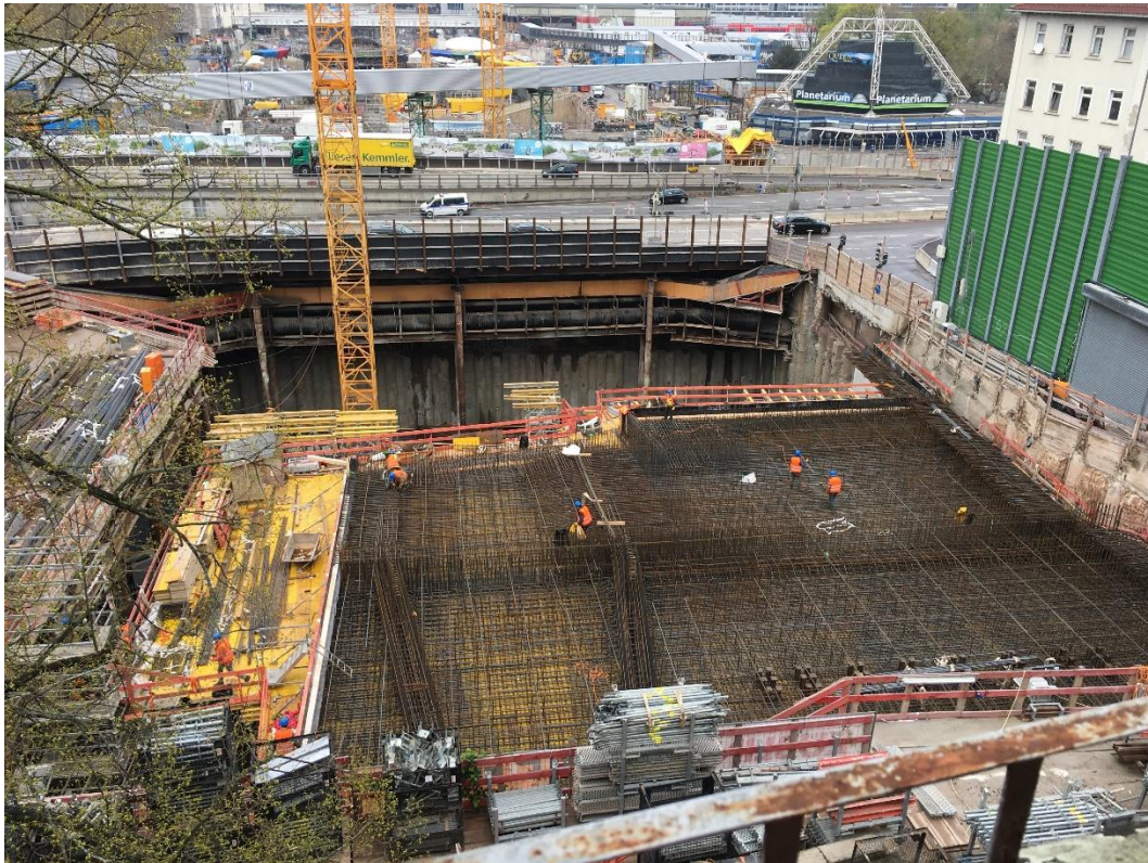
Abbildung 2: Blick auf das Baufeld bei Messende am 09.04.2019
