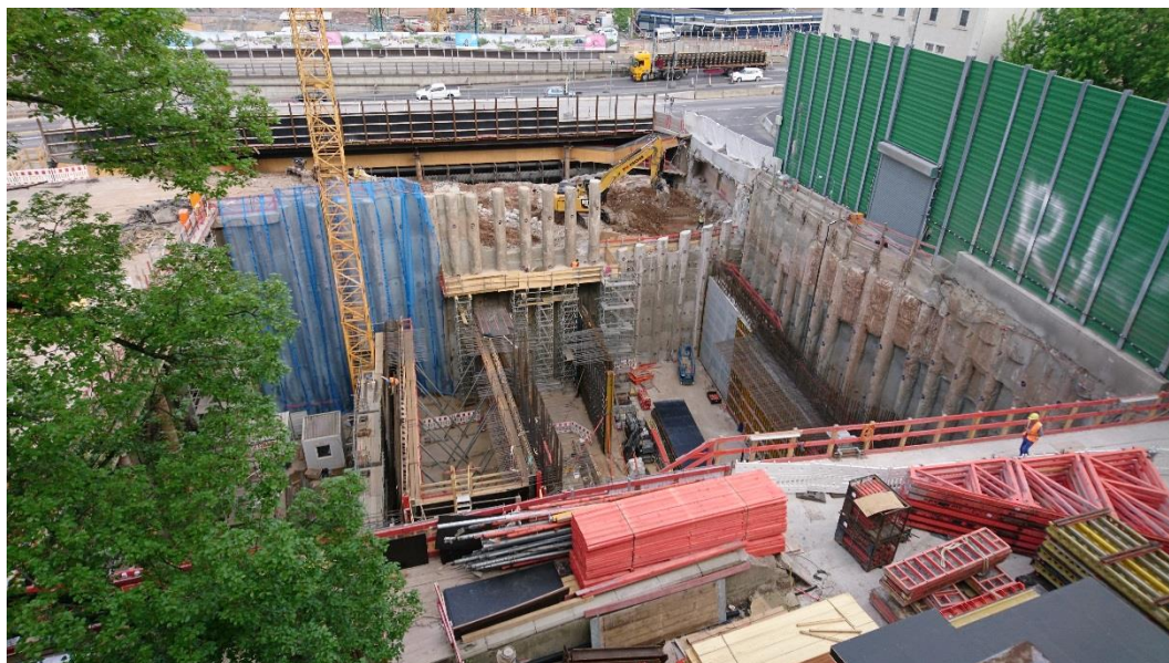
Abbildung 2: Blick auf das Baufeld bei Messende am 23.04.2018
