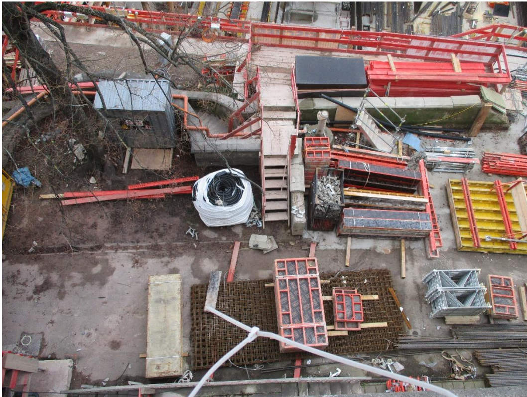
Abbildung 2: Blick auf das Baufeld bei Messende am 29.01.2018
