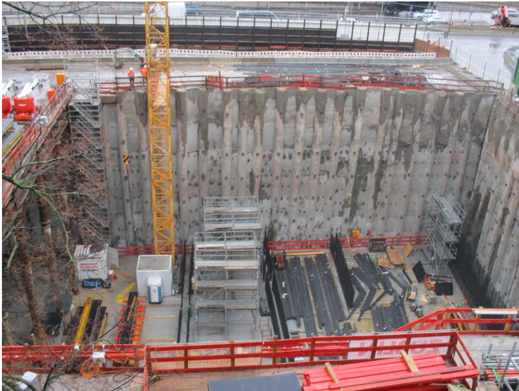
Abbildung 2: Blick auf das Baufeld bei Messende am 22.01.2018
