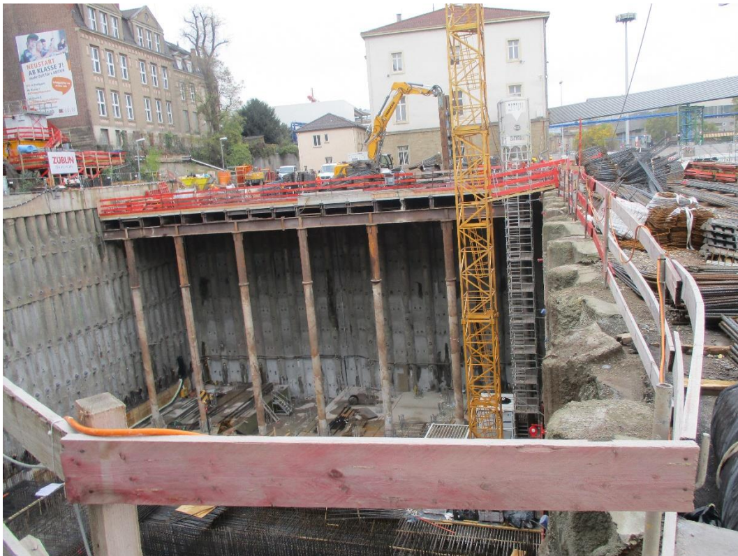
Abbildung 2: Blick auf das Baufeld bei Messende am 06.11.2017
