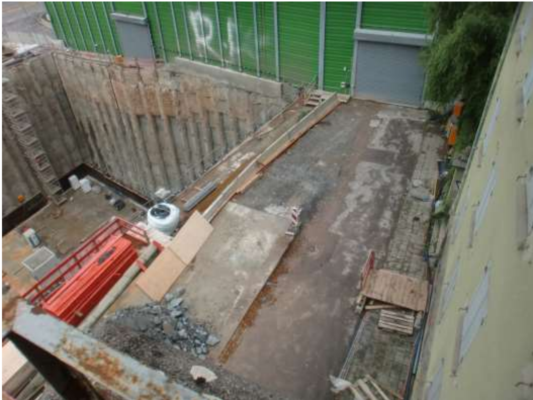
Abbildung 2: Blick auf das Baufeld bei Messende am 09.10.2017
