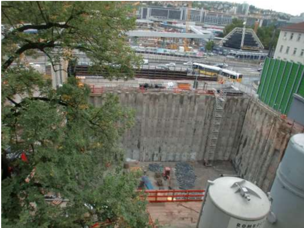
Abbildung 2: Blick auf das Baufeld bei Messende am 18.09.2017
