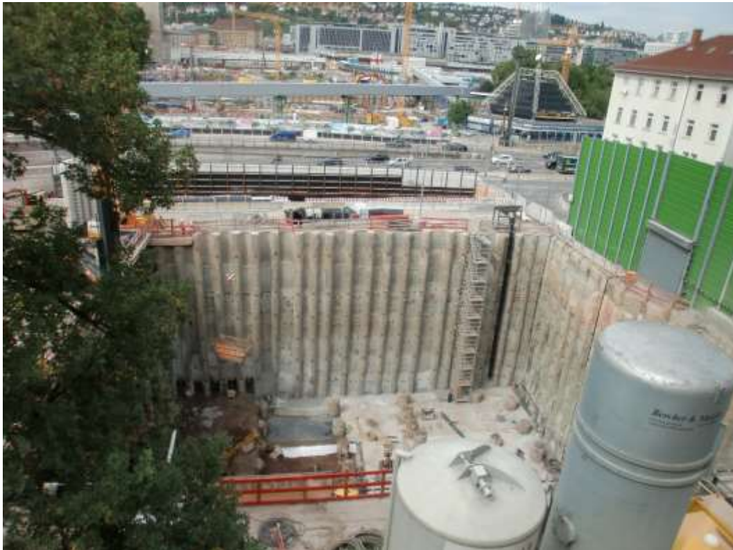
Abbildung 2: Blick auf das Baufeld bei Messende am 04.09.2017
