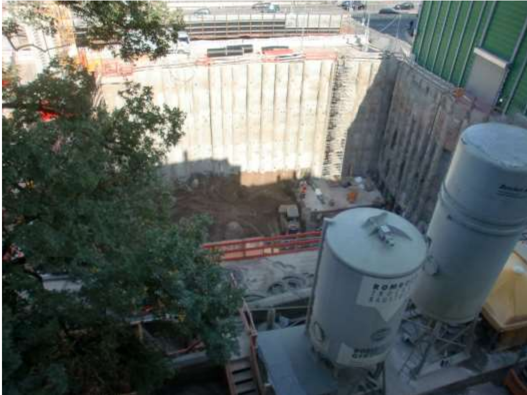
Abbildung 2: Blick auf das Baufeld bei Messende am 22.08.2017
