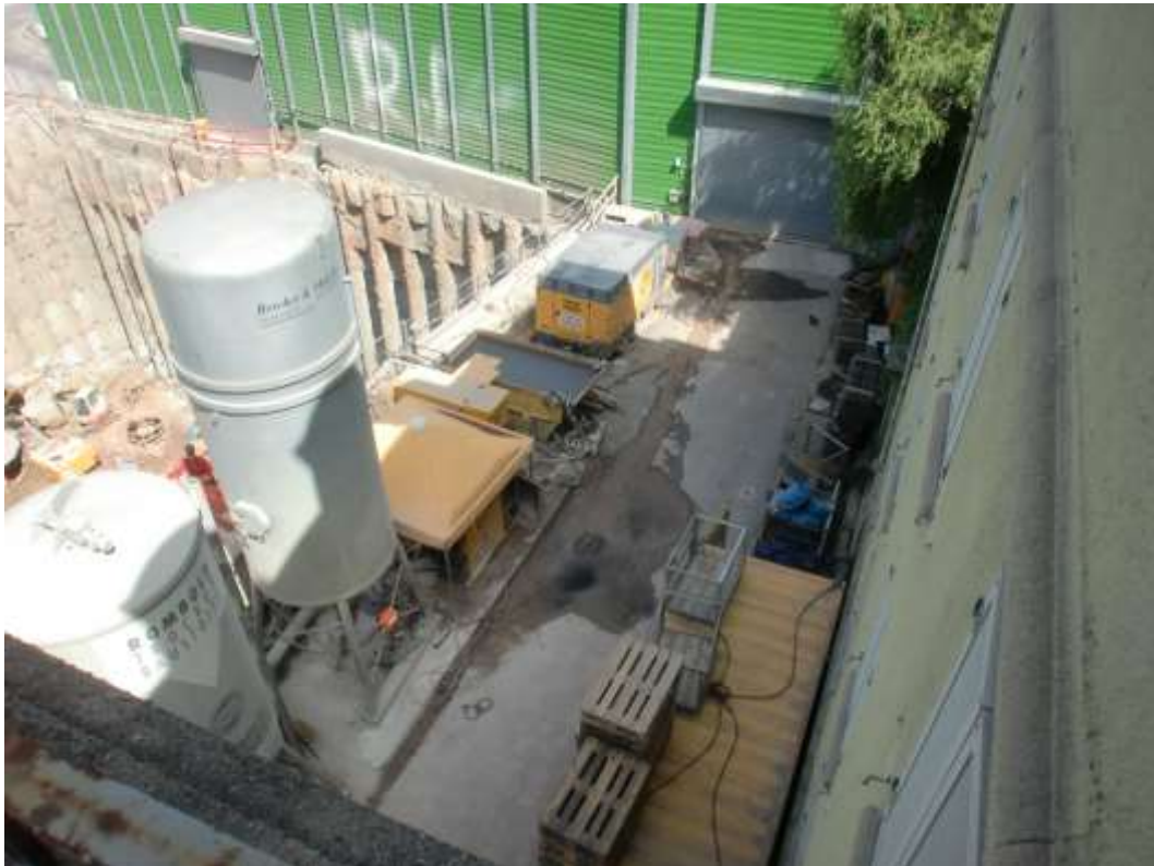
Abbildung 2: Blick auf das Baufeld bei Messende am 07.08.2017
