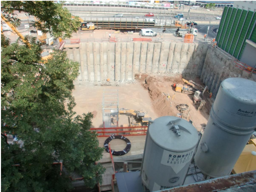
Abbildung 2: Blick auf das Baufeld bei Messende am 26.06.2017
